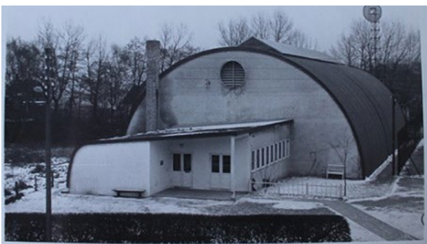
Badmintonhallen, som ligger i tilknytning til områdets tennisbaner, er en markant bygning og et samlingssted. Samtidig fortæller bygningen om områdets historie som "folkets park".
