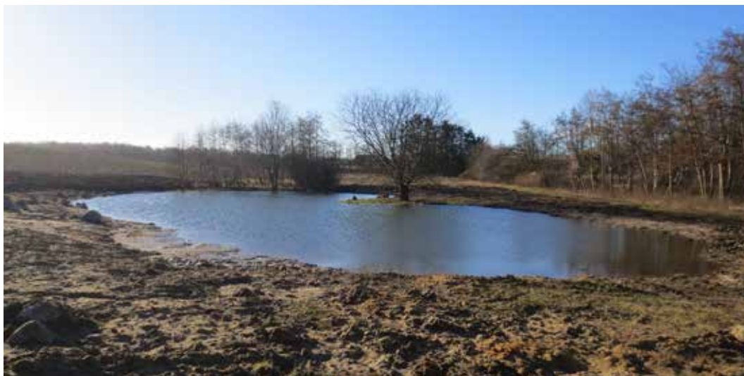
På billedet ses en nygravet sø. Søen er gravet med flade brinker og indpasset i landskabet så formen ser naturligt ud. På billedet ses en nygravet sø. Søen er gravet med flade brinker og indpasset i landskabet så formen ser naturligt ud.
