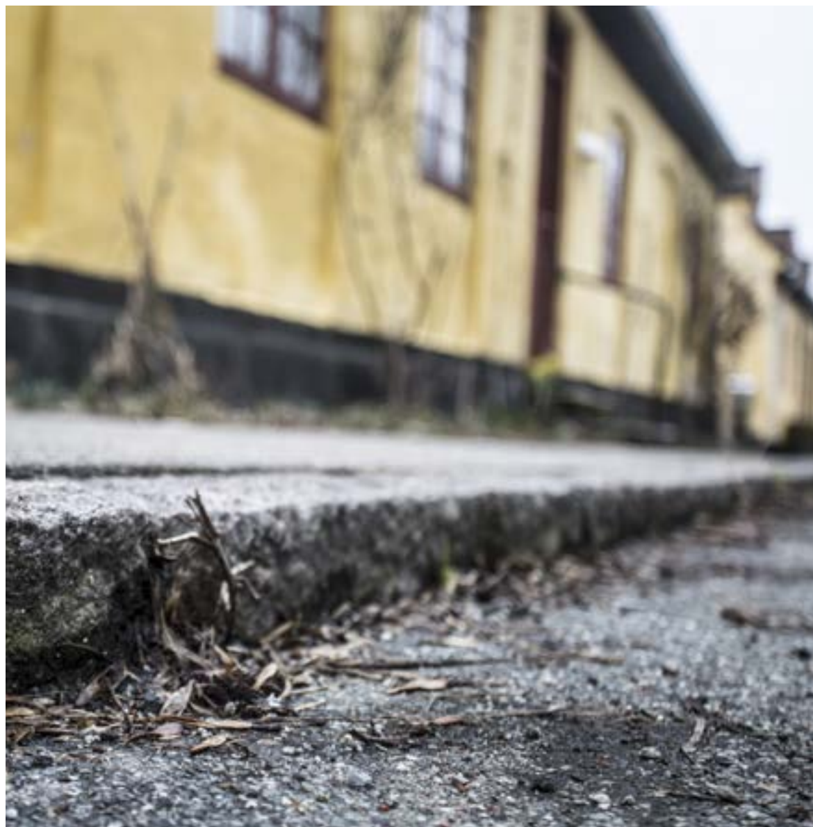
Høj kantsten i Bøssebogergade i Hellebæk
