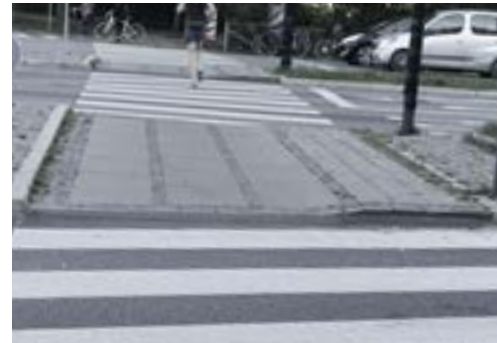
Korrekt udformet helle. Kantstensopspring på 6 cm ved retningsfeltet og nedsænket kantsten og asfaltrampe med "0-kant" på resten af hellen.
