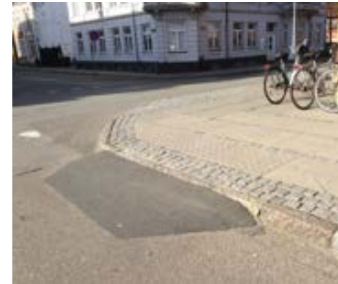
For dyb asfaltrampe. Asfaltrampen er udført med hældning 1:10, men den høje kantsten medfører at rampen går for langt ud i kørebane, hvilket medfører at cyklister og elscootere risikerer at vælte når de kører på langs af rampen. En asfaltrampe må maks. gå 30 cm ud i cykelsti/kørebane. Kan dette ikke opnås pga. for højt kantsten, må kantstenen sænkes.
