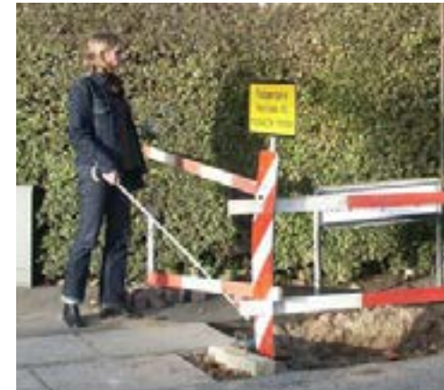
Gravearbejde der er afmærket vha. bomme. Bommene er opstillet for tæt på udgravningen. Fra Færdselsarealer for alle – Håndbog i Tilgængelighed
