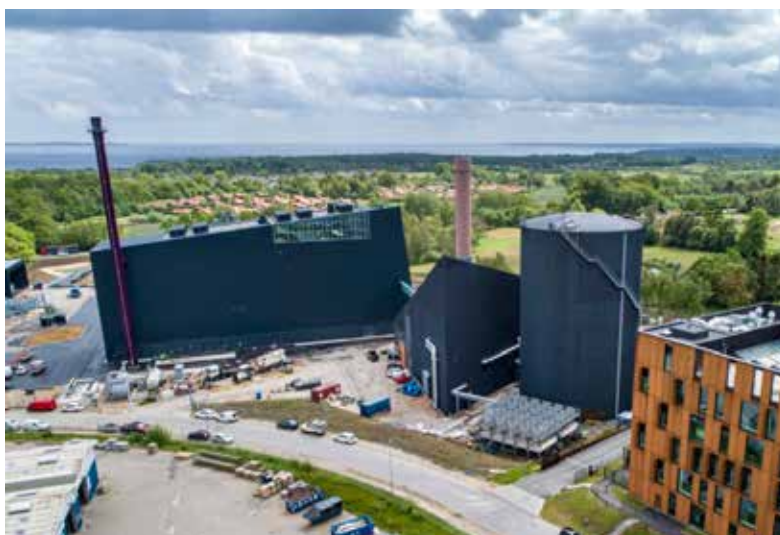
FIGUR 18: VARMEAKKUMULERINGSSTANK PÅ HELSINGØR KRAFTVARMEVÆRK
