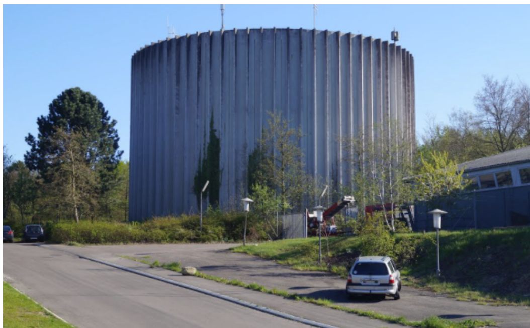
FIGUR 12: 2.800 M 3 VANDTÅRN VED OLE RØMERSVEJ I HELSINGØR
